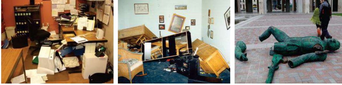
Şekil 10. Dekorasyon elemanları hasar örnekleri [FEMA E-74 , 2012]
