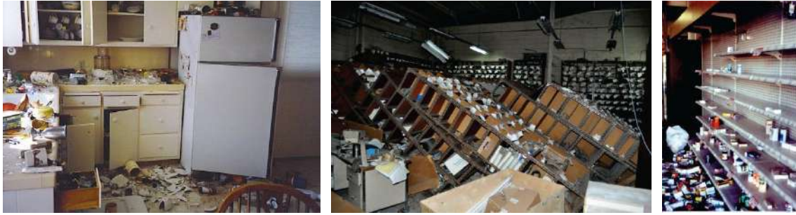
Şekil 10. Depolama ünitelerinden hasar örnekleri [FEMA E-74, 2012]
